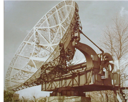
Wurzburg "Riese" Radar Antenna, 7.5 m diameter
