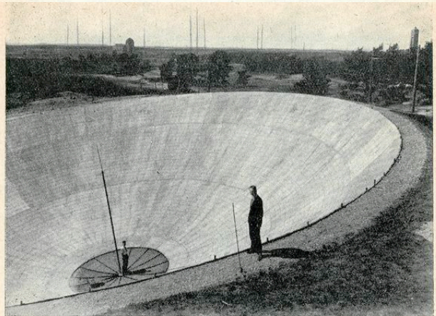
De parabolische zandkuil van de radio-sterrenwacht te Kootwijk. (De middellijn bedraagt 30 meter). In het middelpunt is de antenne duidelijk te zien.
