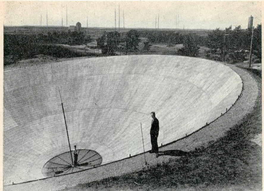
De parabolische zandkuil van de radio-sterrenwacht te Kootwijk. (De middellijn bedraagt 30 meter). In het middelpunt is de antenne duidelijk te zien.
